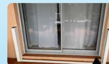
Batardeau posé devant l'ouverture, sur la façade extérieure
